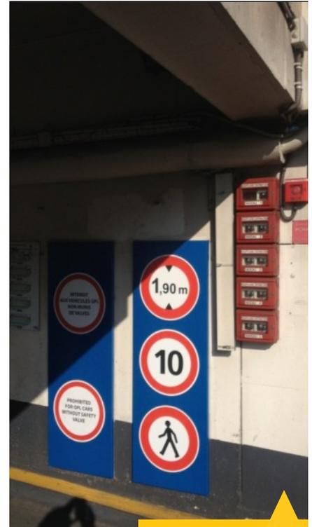
*Eviter de positionner les commandes de désenfumage au droit de la trémie. Il vaut mieux les positionner en amont de la rampe à l'abri des gaz chauds et fumées.*
