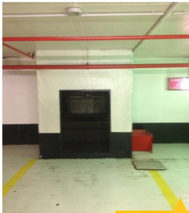
*Ne pas positionner de place de stationnement ou un obstacle devant une bouche de soufflage ou d'extraction : ces places de parking peuvent être réservées aux 2 roues.*
